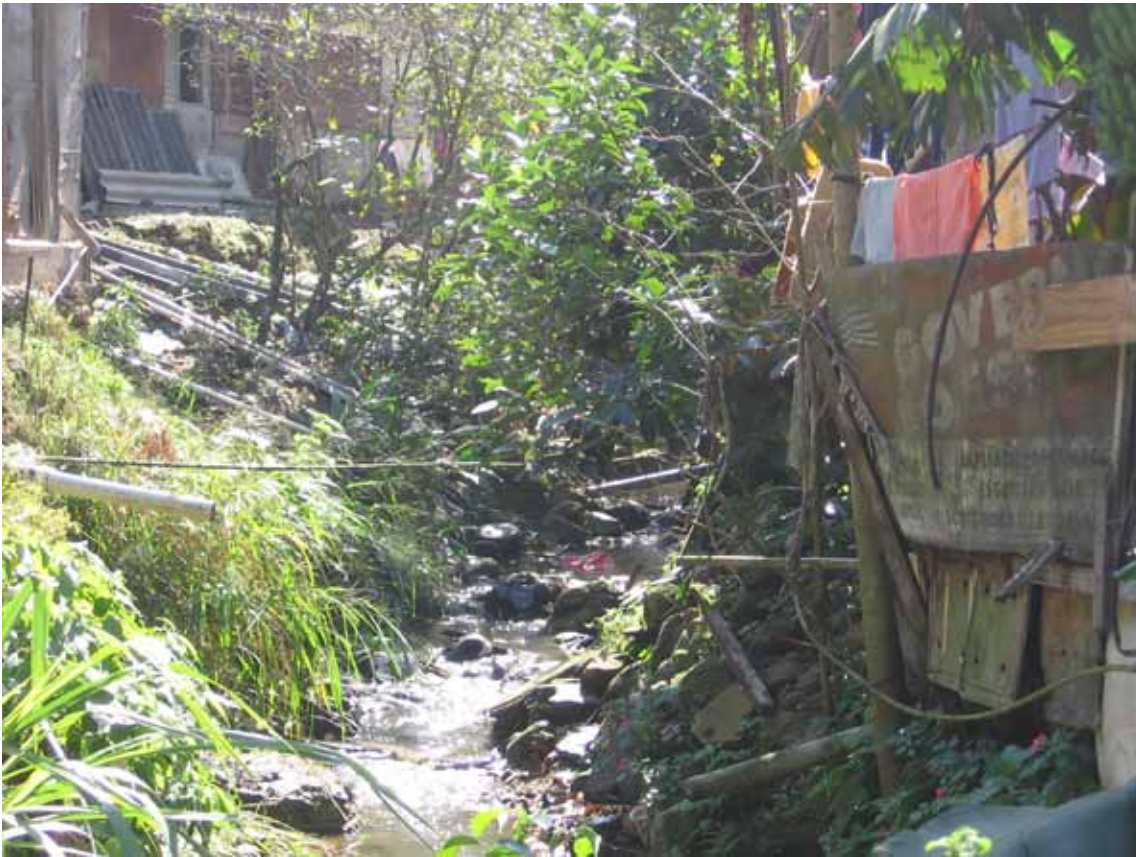
Foto 2. Bairro do Grotão, Cubatão, despejo de esgotos in natura no córrego em área de risco (2009). Foto: Pedro W. Gonçalves
